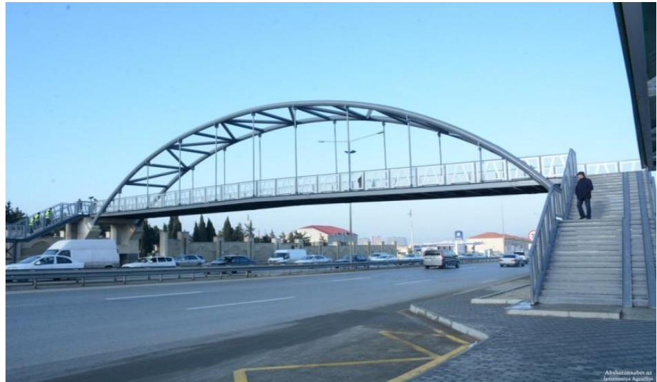
Şək. 3.10. Müxtəlif səviyyəli metal konstruksiyalı yerüstü piyada keçidi
