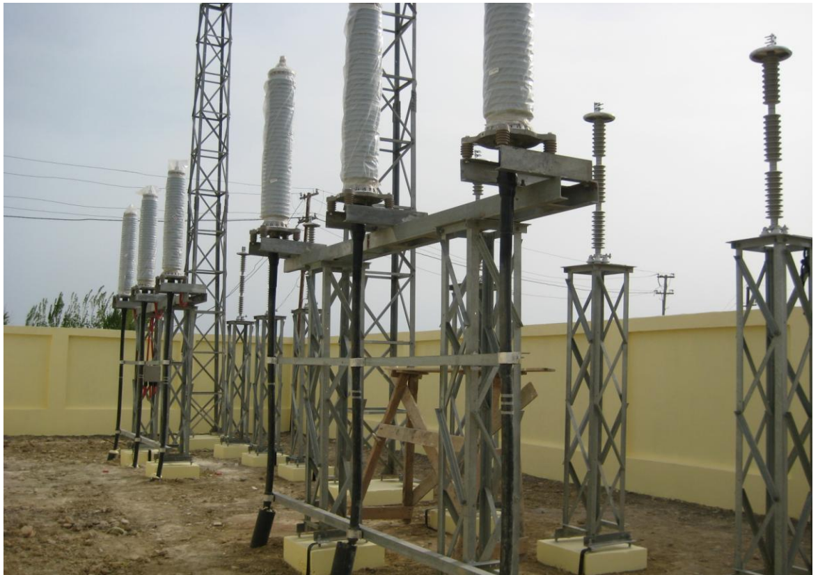
Şək.2.9 OHVT markalı 123 kV-luq kompozit tərkibli sonluq muftası
